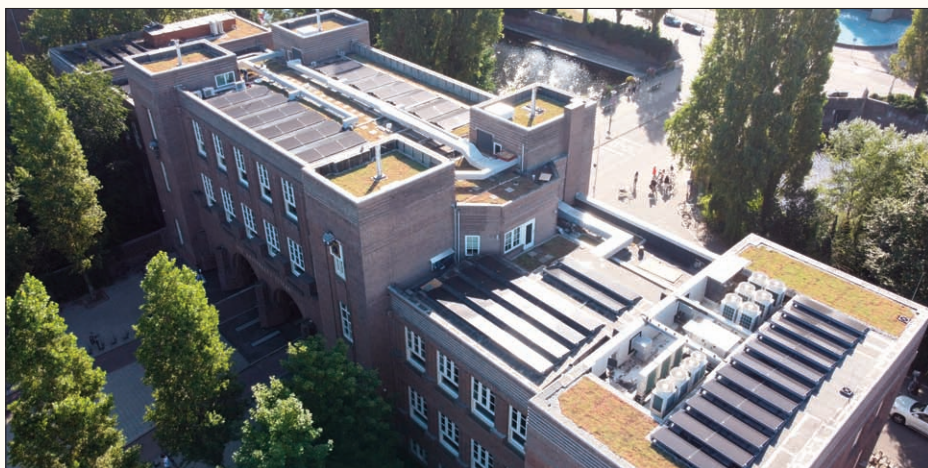
Dak van de school vol met zonnepanelen en warmtepompen
